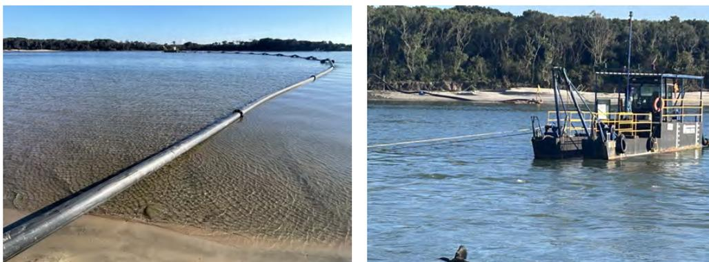
Figura 43. Exemplo de sistema de dragagem de pequeno porte (imagem à direita) onde sedimentos são removidos do fundo e transferidos para uma praia adjacente por meio de tubulação (imagem à esquerda). Autor das fotos: Pedro S. Pereira.
